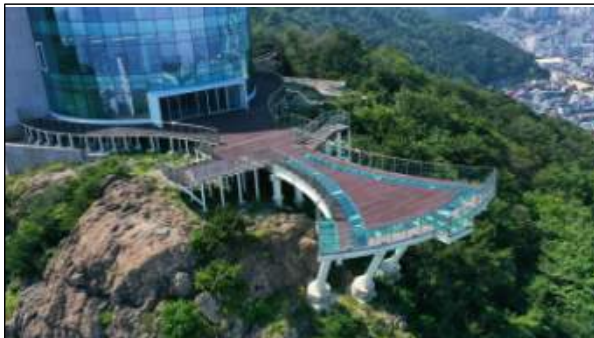
스카이워크 공사 완료('25.7월)
