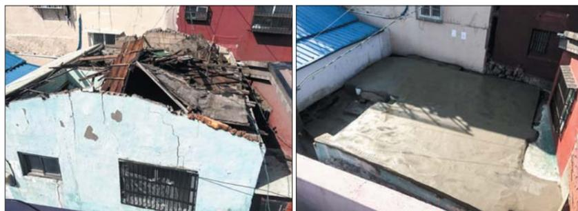
사진은 태풍으로 지붕패널이 날아간 초장동 한 주택의 철거 전(사진 왼쪽)과 후의 모습.
