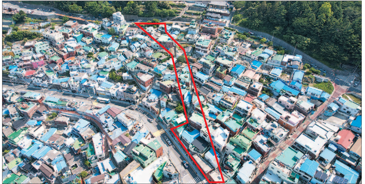
사진은 산복도로 해돋이로와 천마산로를 잇는 도로개설 공사 구간.
