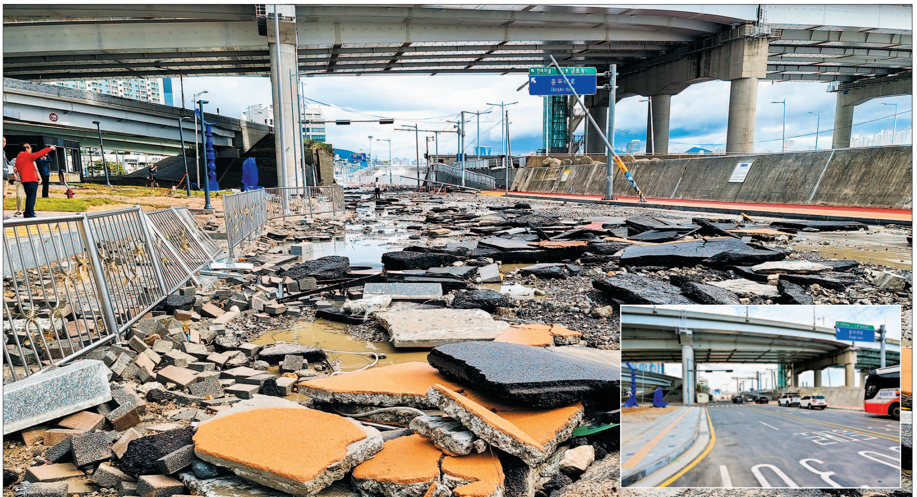
사진은 태풍 ‘힌남노’로 인해 도로 아스팔트와 보도가 크게 파손돼 전쟁터를 방불케 했던 등대로(큰 사진)와 이를 만에 응급복구 작업을 완료해 차량 통행이 재개된 같은 위치의 등대로(작은 사진) 모습.
