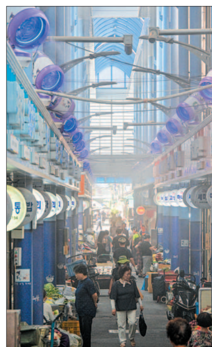
사진은 충무동새벽시장 김해골목에 설치된 증발냉방장치 가동 모습. 점포 위에 부착된 둥근 팬에서 에어프로그가 분사되고 있다.
