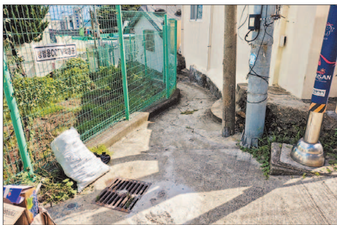
사진은 산복도로 이음길 정비사업으로 추진된 남부민2동 골목길의 파손부 보수 및 흙콘크리트 포장공사 전후의 모습.
