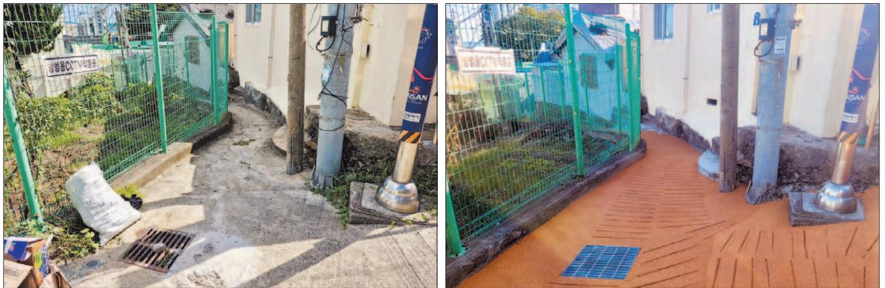
사진은 산복도로 이음길 정비사업으로 추진된 남부민2동 골목길의 파손부 보수 및 흙콘크리트 포장공사 전후의 모습.
