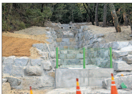
사진은 최근 황폐계류 보전 사업이 완료된 구덕산 자락의 공사 현장.
